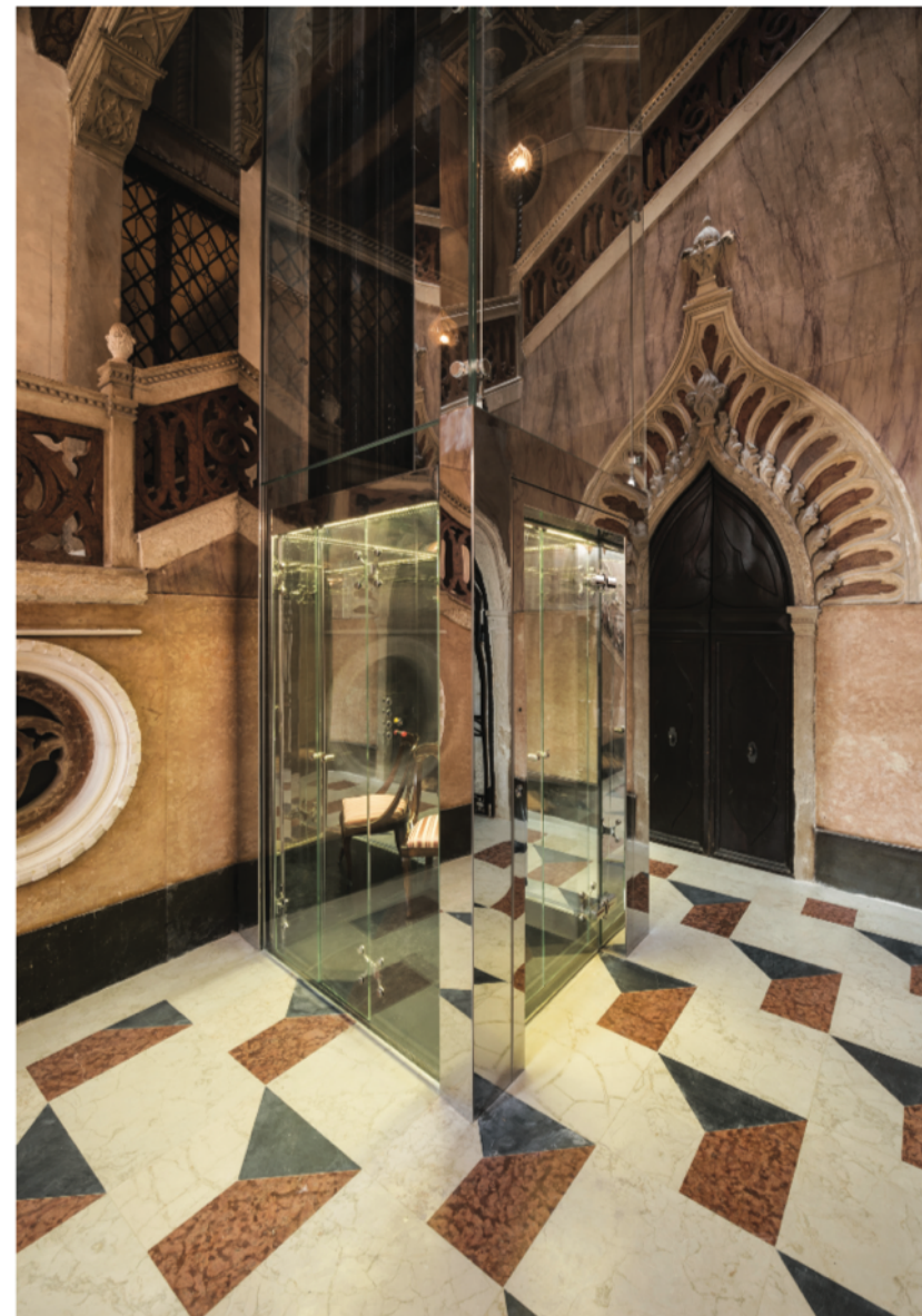
Fig.4 - Piattaforma elevatrice di Palazzo Gritti con la cabina ferma nell'androne d'ingresso. L'idea di base di questo progetto è stata realizzare una piattaforma elevatrice di cui si sarebbe dovuta vedere solo la cabina in movimento. Per questo motivo sono stati scelti materiali come il cristallo e un acciaio riflettente a specchio per le strutture e i profili.
