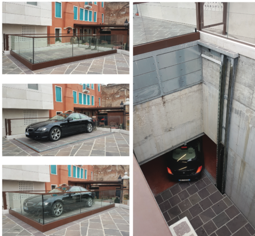
Fig.1 - Piattaforma elevatrice per automobili dell'Hotel Santa Chiara a Piazzale Roma, Venezia. A sinistra si vede una sequenza delle fasi di funzionamento della piattaforma, mentre a destra il vano di corsa della piattaforma e l'entrata al parcheggio sottostante l'albergo.
