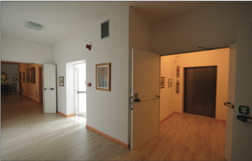
Fig.3 - Questo ascensore è un montalettighe antincendio. Al piano terra è connesso direttamente all’sterno tramite un doppio filtro REI.
