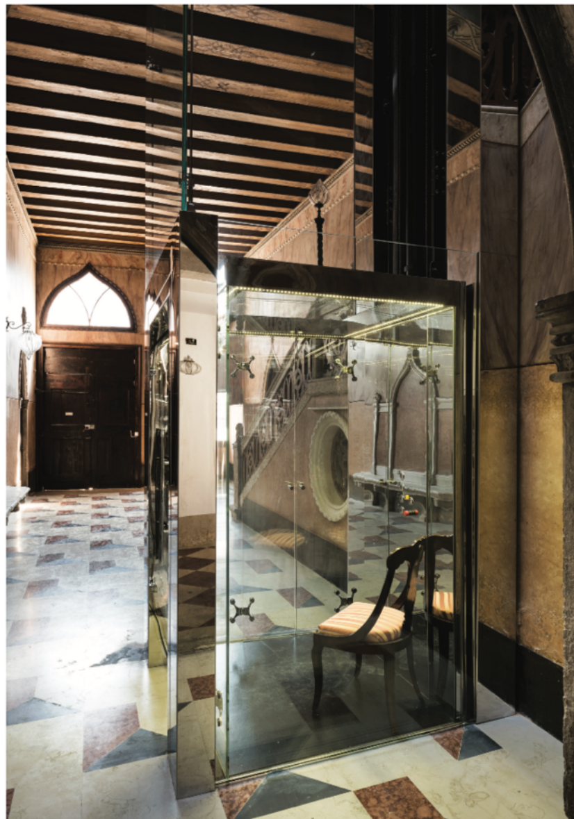
Fig.1 - Atrio di Palazzo Gritti con la piattaforma elevatrice.
