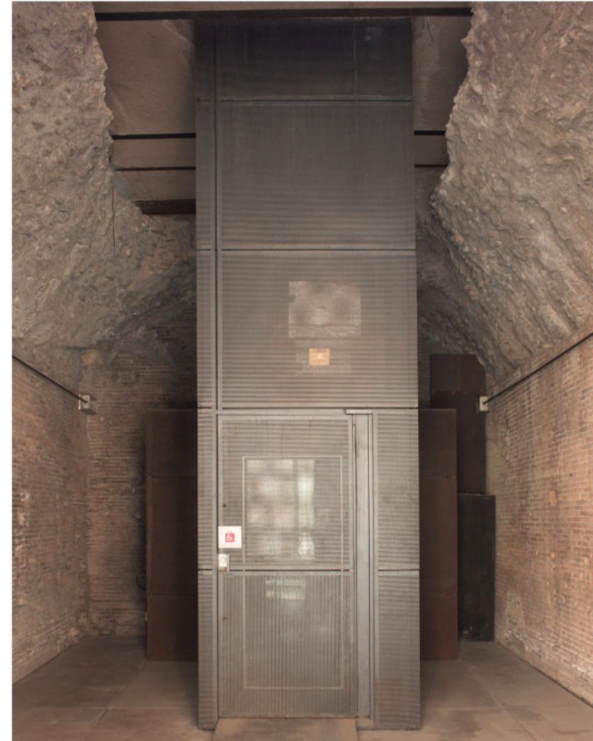
Fig.3 - Ascensore del Museo dei Fori Imperiali: sbarco alla quota di via Biberatica.
