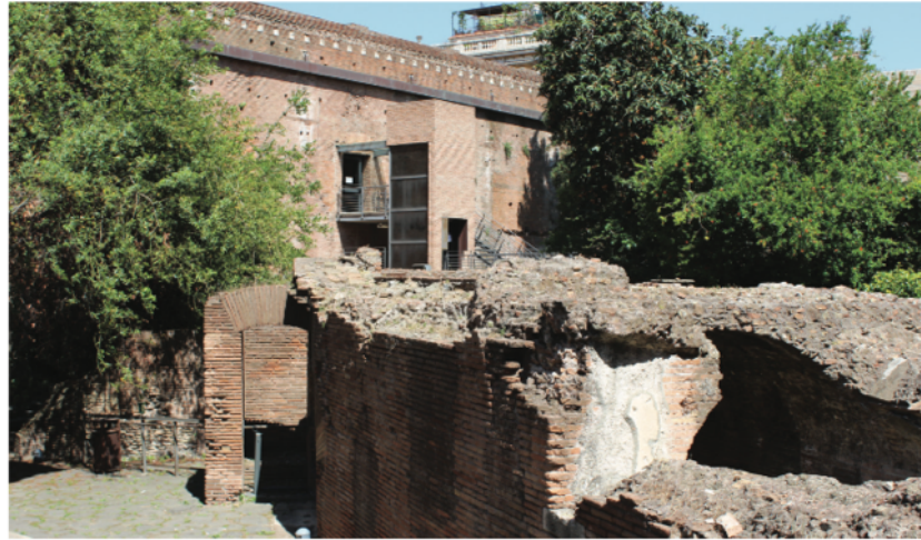
Fig.1 - Ascensore oleodinamico all'interno del Giardino delle Milizie ai Mercati di Traiano. Mette in comunicazione le sale del Museo dei Fori Imperiali disposte sui tre livelli della Grande Aula e del Corpo Centrale con lo spazio esterno.
