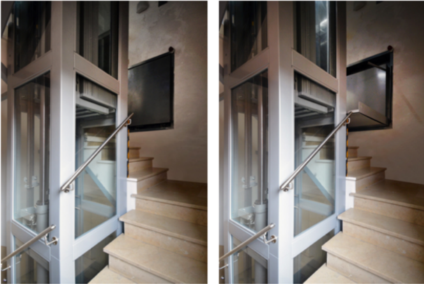
Fig.1 - Questa piattaforma elevatrice è stata installata all'interno del vano scale di un edificio residenziale a Venezia che si trova in contiguità con la Scuoletta dei Tiraoro e Battioro e dell'adiacente Chiesa di San Stae. Il nuovo sistema di sollevamento è stato predisposto a servizio dell'appartamento del terzo piano con lo scopo di facilitarne il raggiungimento. Si tratta di uno spazio molto limitato e la mancanza di superficie da destinare allo sbarco di emergenza è stato risolto con l'inserimento di uno sbarco a scomparsa nella parete.
