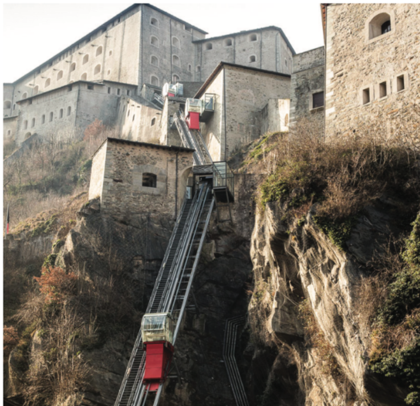
Fig.1 - Ascensori inclinati che collegano il Forte di Bard (Valle d'Aosta), dove ha sede un polo museale, con un parcheggio posto a valle. Il sistema si compone di 3 diversi ascensori caratterizzati da inclinazioni diverse e supera un dislivello di 76 m.
