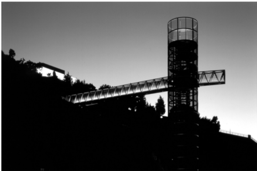
Fig.1 - Ascensore panoramico che connette la città storica con il Castello della Concezione (quota +37 m dalla quota stradale inferiore) a Cartagena, Spagna.
